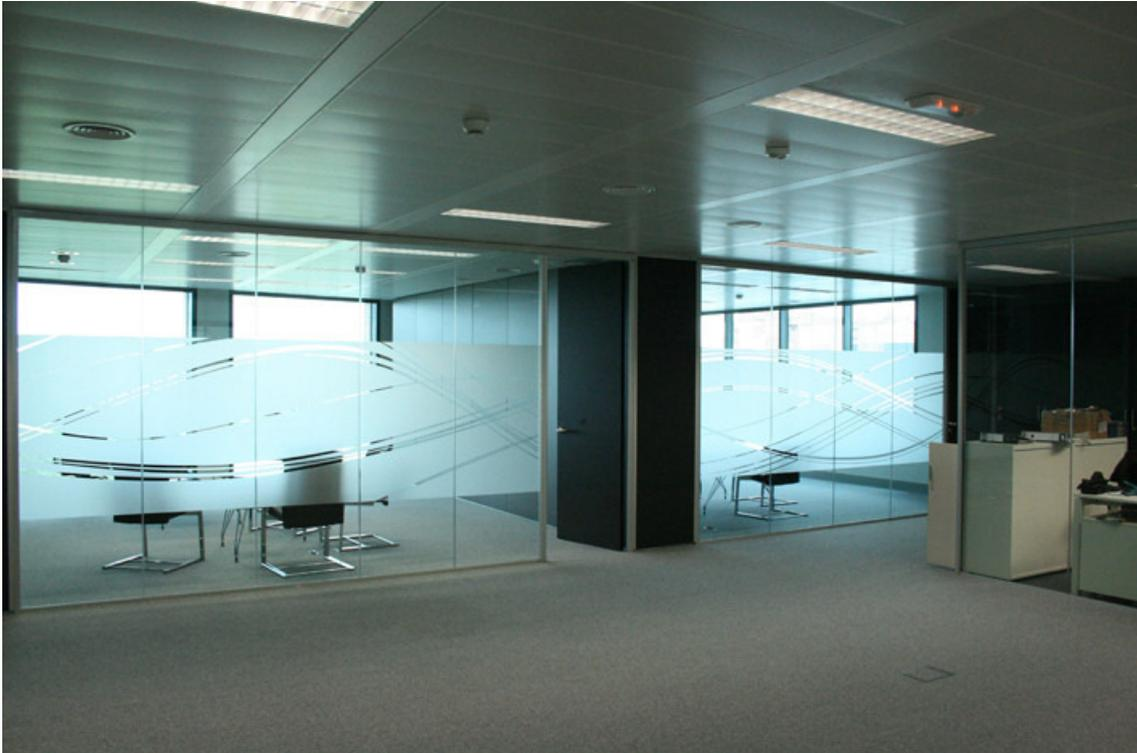
Esta fotografía nos muestra un ejemplo de mampara todo cristal construida con laminar transparente decorado posteriormente con vinilo mate, todo ello sujeto perimetralmente con perfilaría de aluminio.
